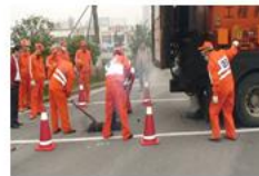
厂拌冷再生技术
