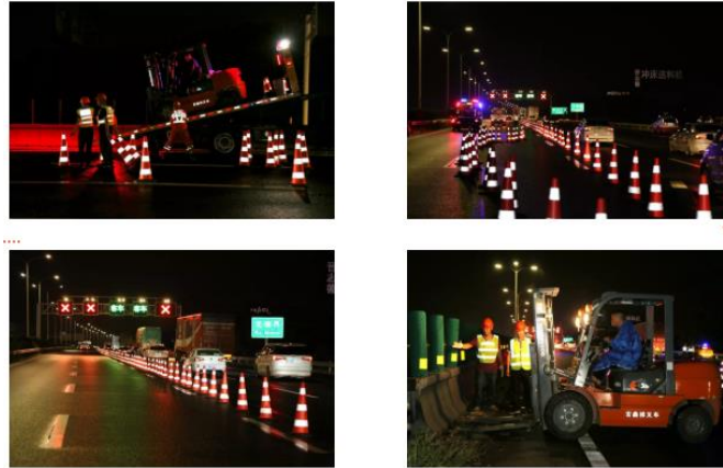
图注：全国首个超大流量路段智慧扩容示范工程核心项目——沪宁高速公路硕放至东桥枢纽路面养护工程正式开工
