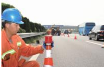
图注：作业人员转配物联网智慧锥桶
